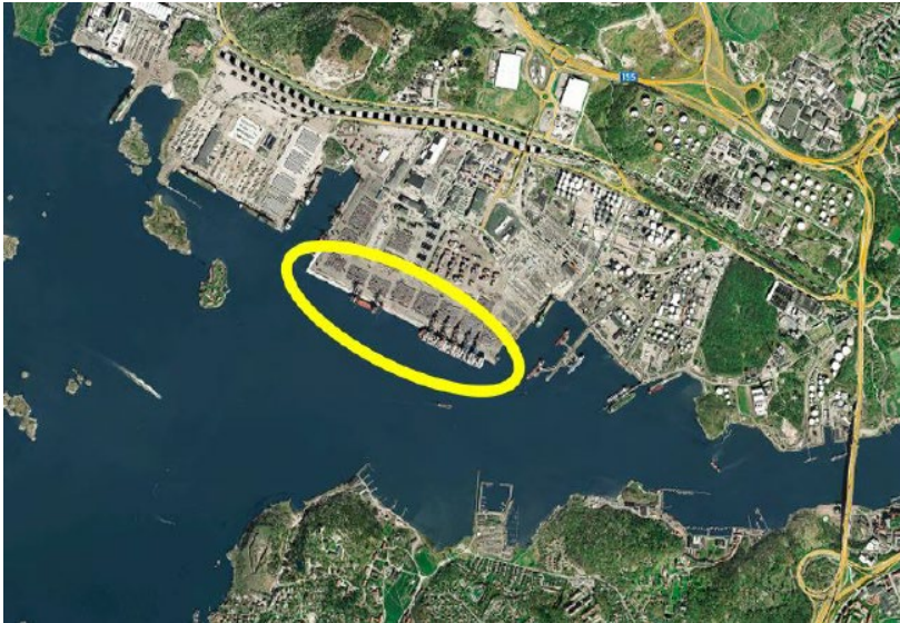
Figur 2. Skandiahamnen inom Göteborgs hamn, södra kajen är inringad. Figur hämtad från teknisk beskrivning av kajförstärkning och fördjupning av hamnbassäng (Harrysson, 2020).
