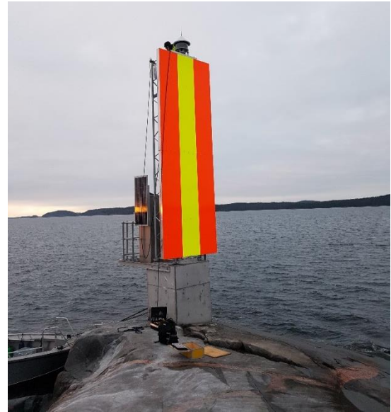
Figur 4. Exempelbild på fackverksmast med dagermärke.
