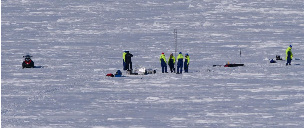
Här byggs forskningsstationen "Met-Alley" upp
