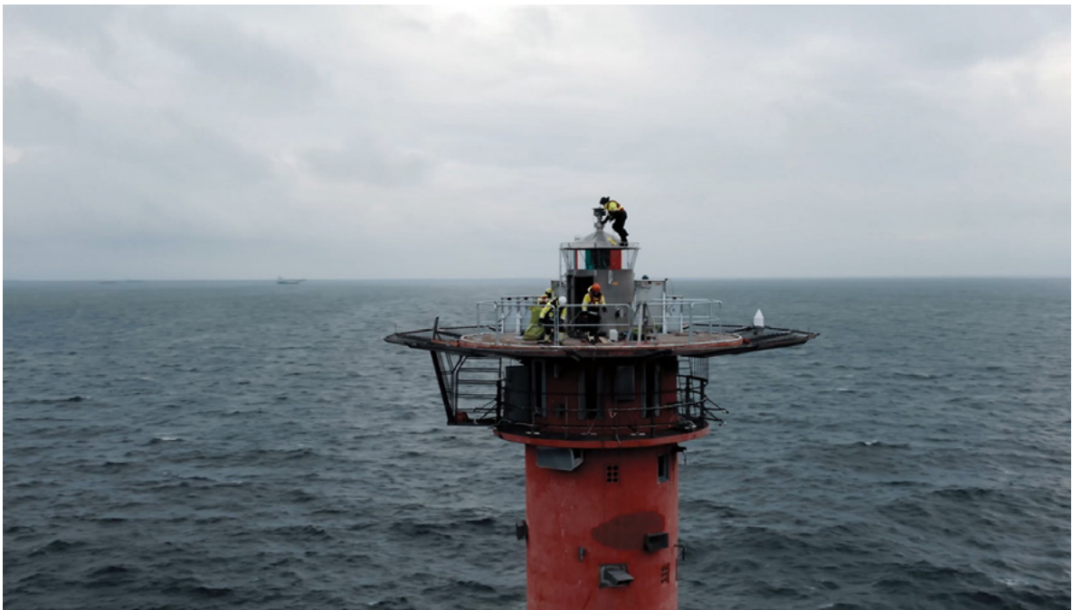
Trubadurens fyr byggs om till drift med till med energiförsörjning via solpaneler. Foto: Brixly
