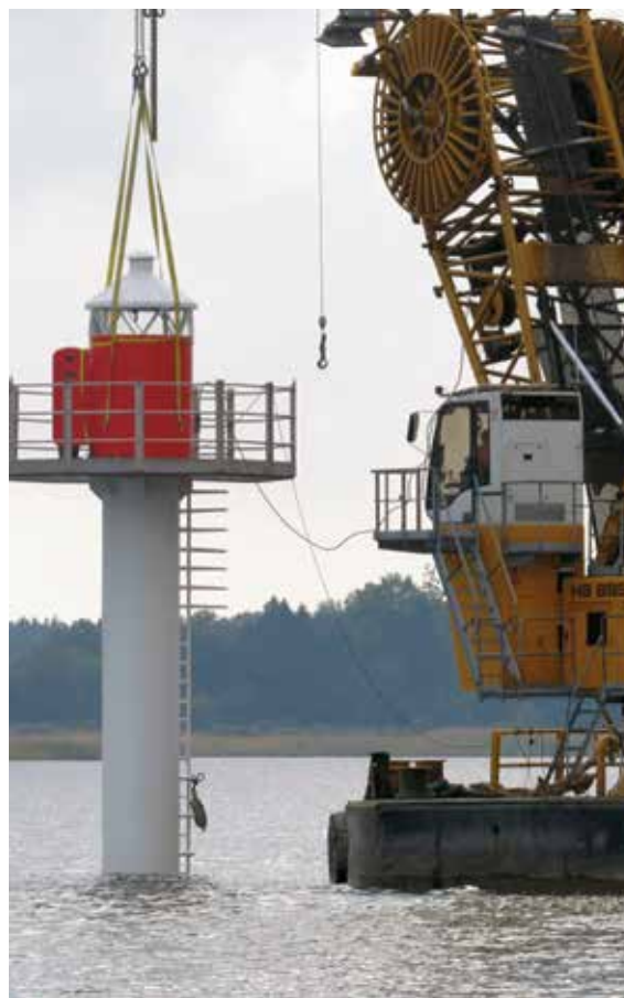
En kassunfyr är en fast fyr som är placerad på havsbotten utanför land. Den är helt eller delvis byggd på land och har gjutits fast på havsbotten. Foto: Sjöfartsverket.
