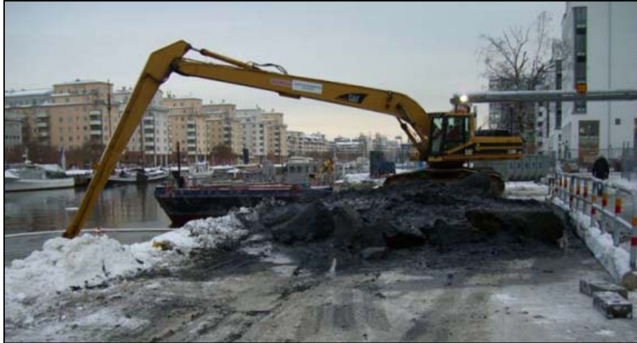
Figur 6. Schaktning (muddring) med grävmaskin. Foto: Per Vallander, Sweco.
