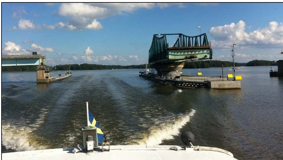
Figur 5:1 Hjulstabron i öppet läge. (Foto: Henrik Wenngren, Sweco)
