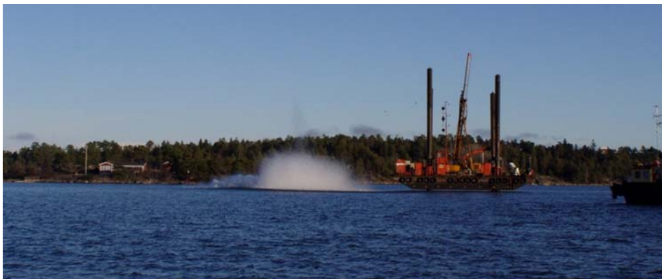
Figur 7:7 Undervattenssprängning med borrhplattform i vänteläge
