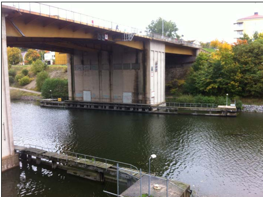
Figur 4:52 Ledverk av trä på pålar av trä vid Mälarbron (Foto: Henrik Wenngren, Sweco).
