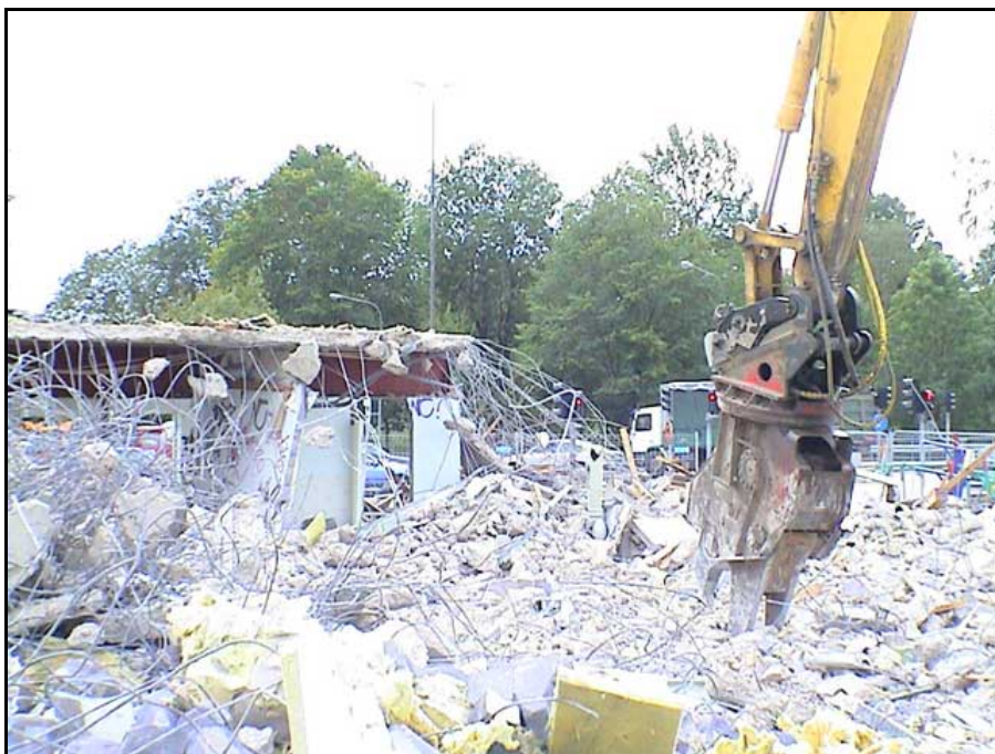
Figur 7:2 Grävmaskin med krosstång för rivning (Källa: Entreprenad AB Sven Segerström)
