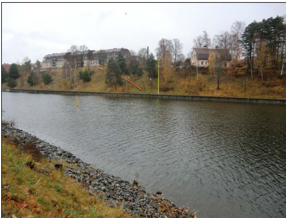
Figur 4:50 Spont på östra sidan av norra kanalen (Foto: Alrik Lundin, Sweco).
