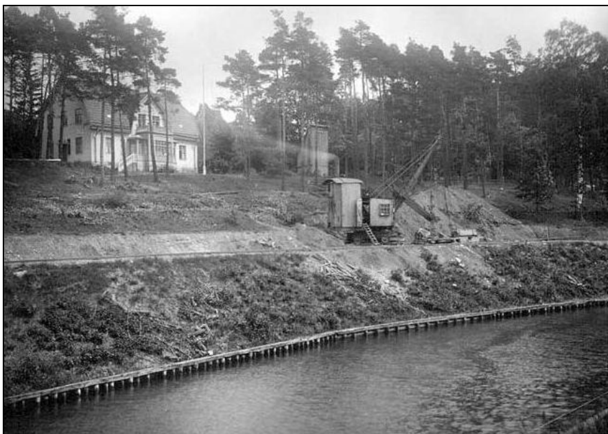
Figur 3:21 Bilden visar den stora avschaktningen som företogs vid byggandet av befintlig kanal. (Bild från Sjöfartsverkets samling via Olle Holmberg)
