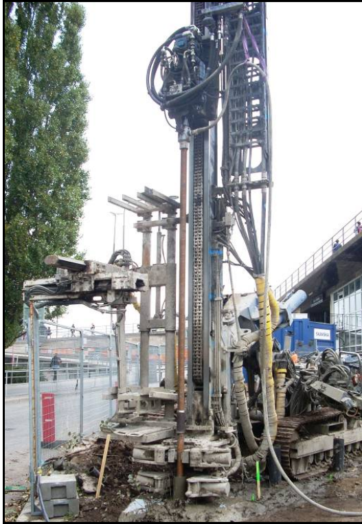
Figur 7:10 Installation av injekteringspåle med borrhög (Foto: Henrik Tideström, Sweco)
