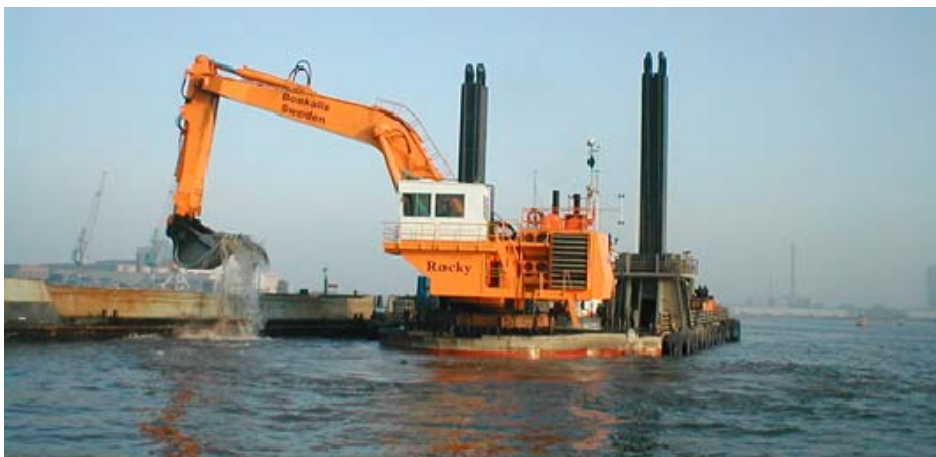
Figur 7:5 Enskopeverk på stödbensponton (Källa: Boskalis Sweden AB)
