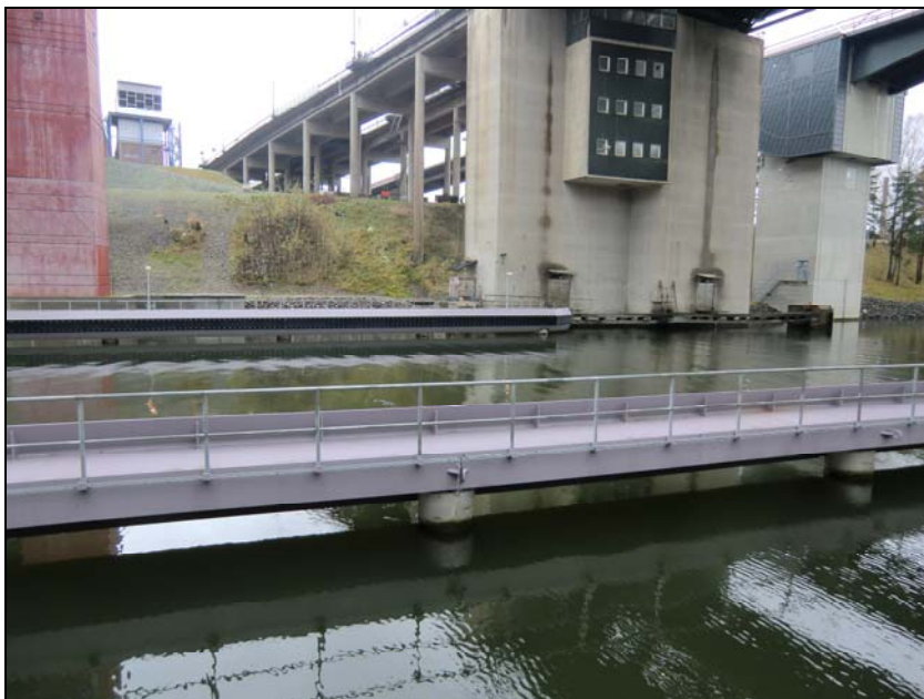
Figur 4:10 Befintligt ledverk, vid Järnvägsbron fram till E4/E20-broarna, av stål grundlagda på stålpålar. (Foto: Alrik Lundin, Sweco).
