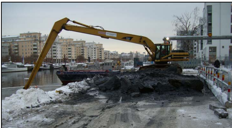
Figur 7:3 Schaktning med hjälp av grävmaskin stående på land (Foto: Per Vallander, Sweco)
