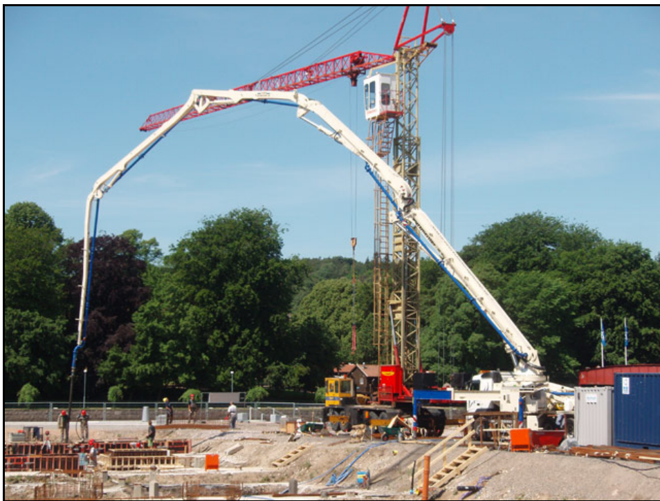
Figur 7:12 Betongpump (Källa: Everts Betongpump AB)
