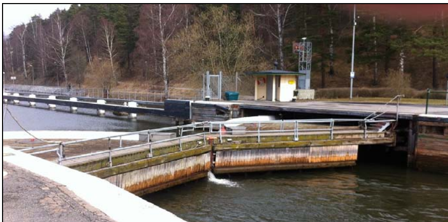
Figur 4:32 Norra (uppströms) slussportarna. Den gula byggnaden mitt i bilden är slussnedgångsöverbyggnaden. (Foto: Henrik Wenngren, Sweco).
