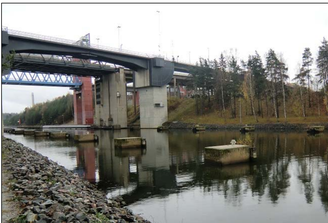
Figur 4:9 Broarna över södra kanalen. Närmast Saltsjöbron, i mitten E4/E20-broarna och längst bort Järnvägsbron. I kanalen står de dykdalber som fungerar som vägledning för sjötrafiken (Foto: Alrik Lundin, Sweco).
