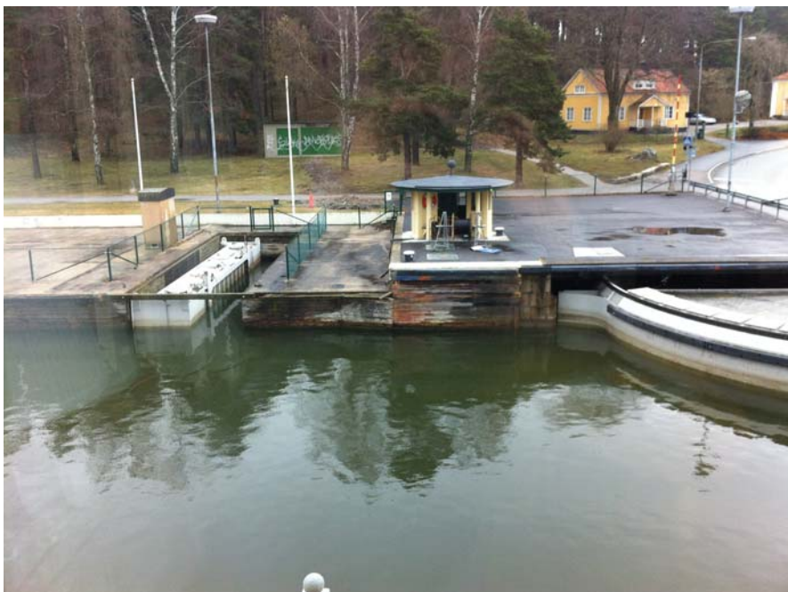
Figur 4:33 Dagens reservport vid sin förtöjningsplats. Mellan reservportens förtöjningsplats och portkammaren står slussnedgångsöverbyggnaden. (Foto: Henrik Wenngren, Sweco).
