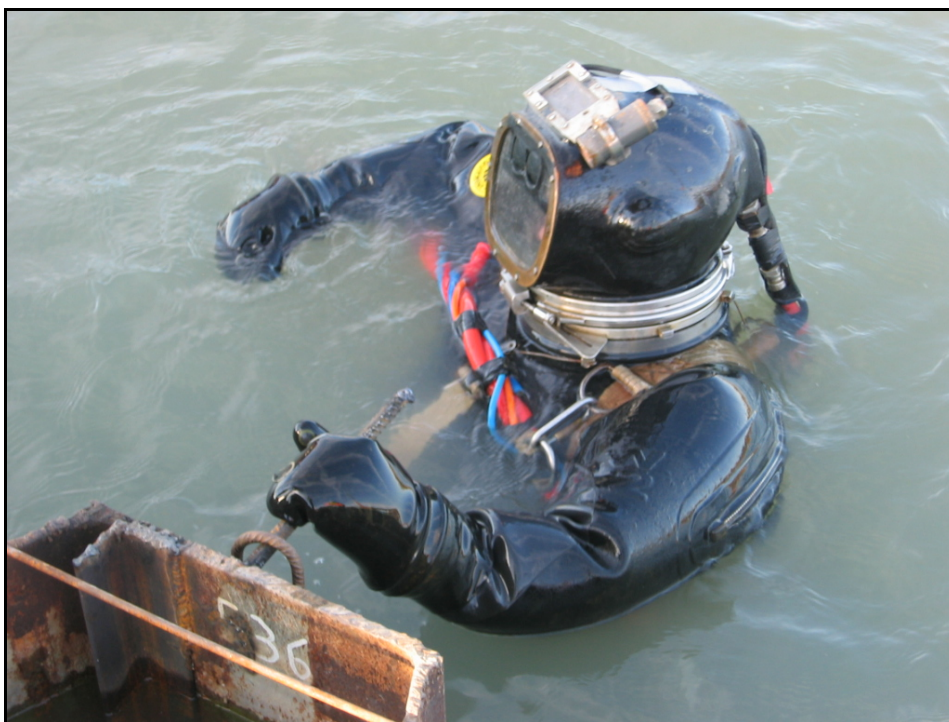
Figur 7:11 Dykare förbereder formsättning och armering av krönbalk på spontkaj (Foto: Gregor Rolski, Sweco)
