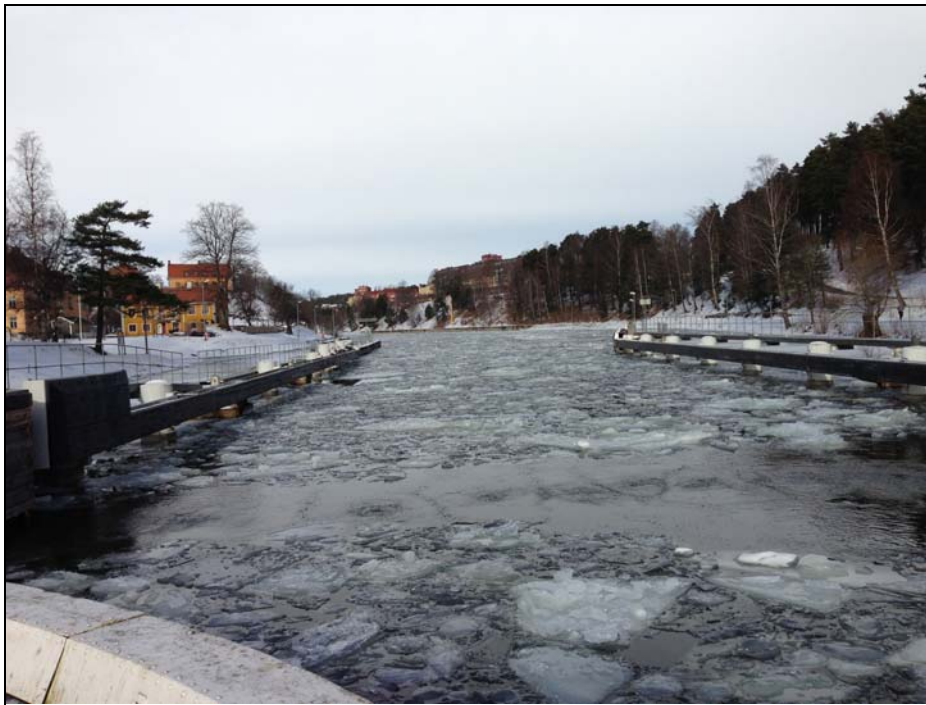
Figur 4:42 Ledverk norr om slussen (Foto: Henrik Wenngren, Sweco).
