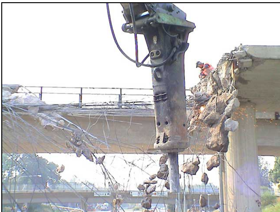
Figur 7:1 Rivning av bro med hydraulhammare monterad på grävmaskin (Källa: Entreprenad AB Sven Segerström)
