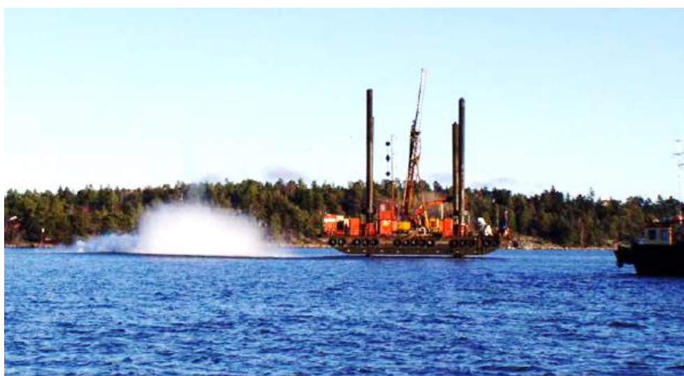
Figur 13. Undervattenssprängning med borrhplattform.
