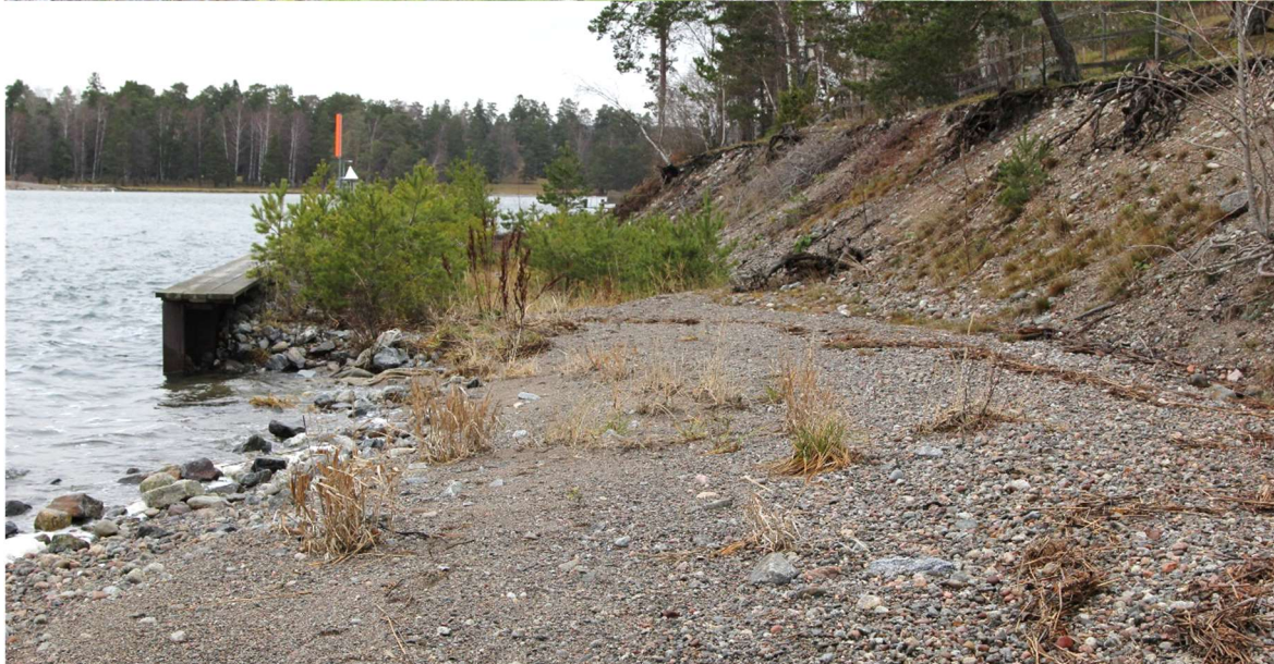
Figur 18 Södra Brandalsund. Av erosionsskäl har en spont tidigare slagits ned, vilket syns till vänster.
