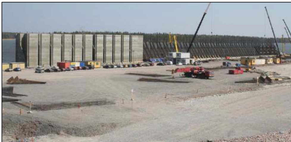
Figur 6.7.1.3 Exempel på tillverkning av element till en stödmurskaj. Skivelementen står närmast kameran, stödmurselementen är vända ut mot kajen. Elementen i exemplet tillverkas på en kaj där de kunde hämtas av en pontonkran.
