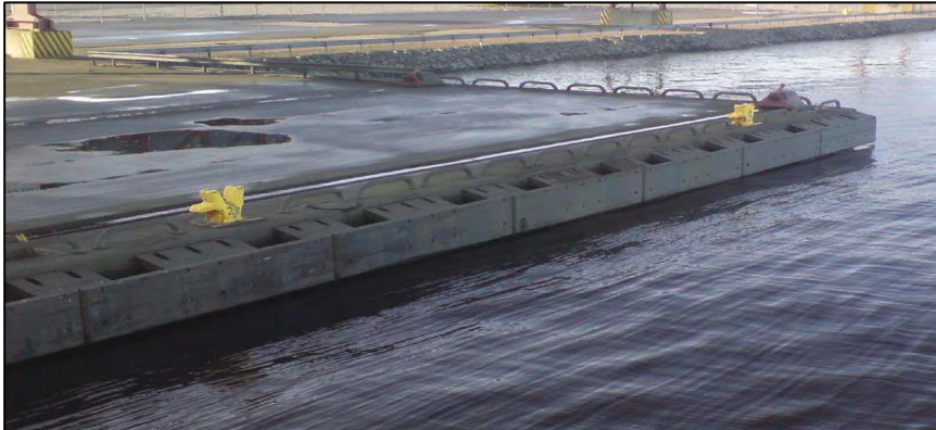
Figur 6.7.3 Kontinuerlig liggande MV-fender. I de gula pollarna på kajen förtöjs fartygen.
