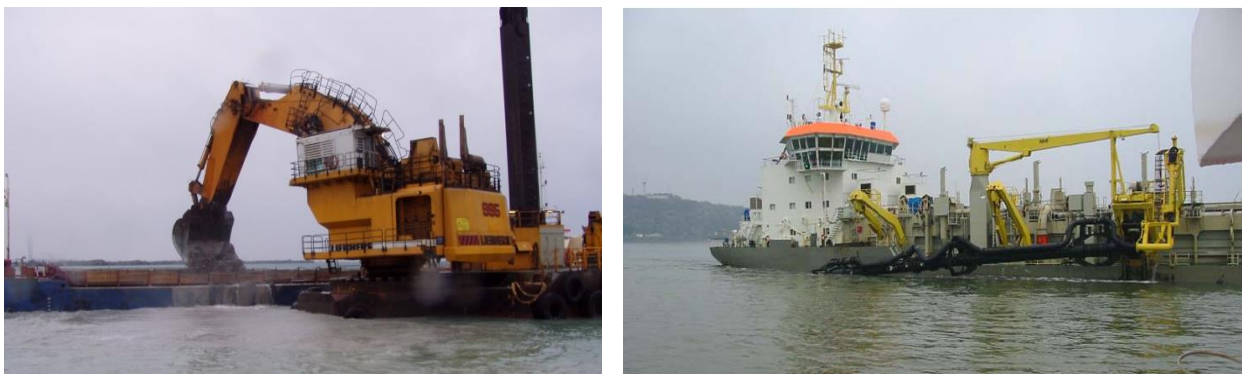
Figur 6.4.2.1 Enskopeverk till vänster och Trailer (TSHD) till höger.
