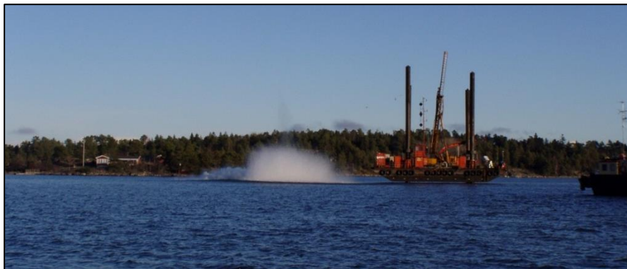
Figur 6.4.2.3 Undervattenssprängning med borrplattform i väntläge.
