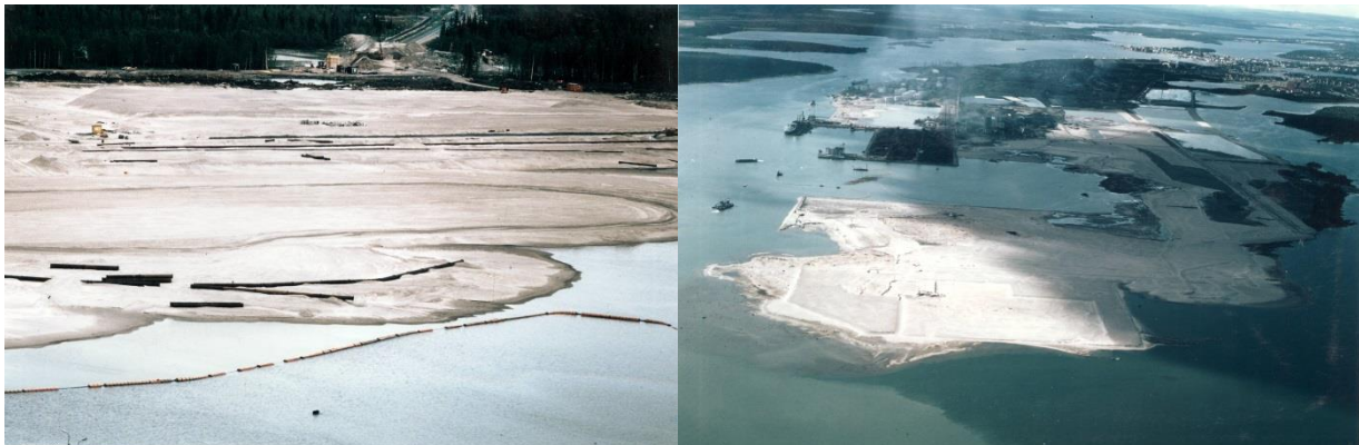
Figur 3.2.2: Foton från arbete med utfyllnad inför Stålverk 80.
