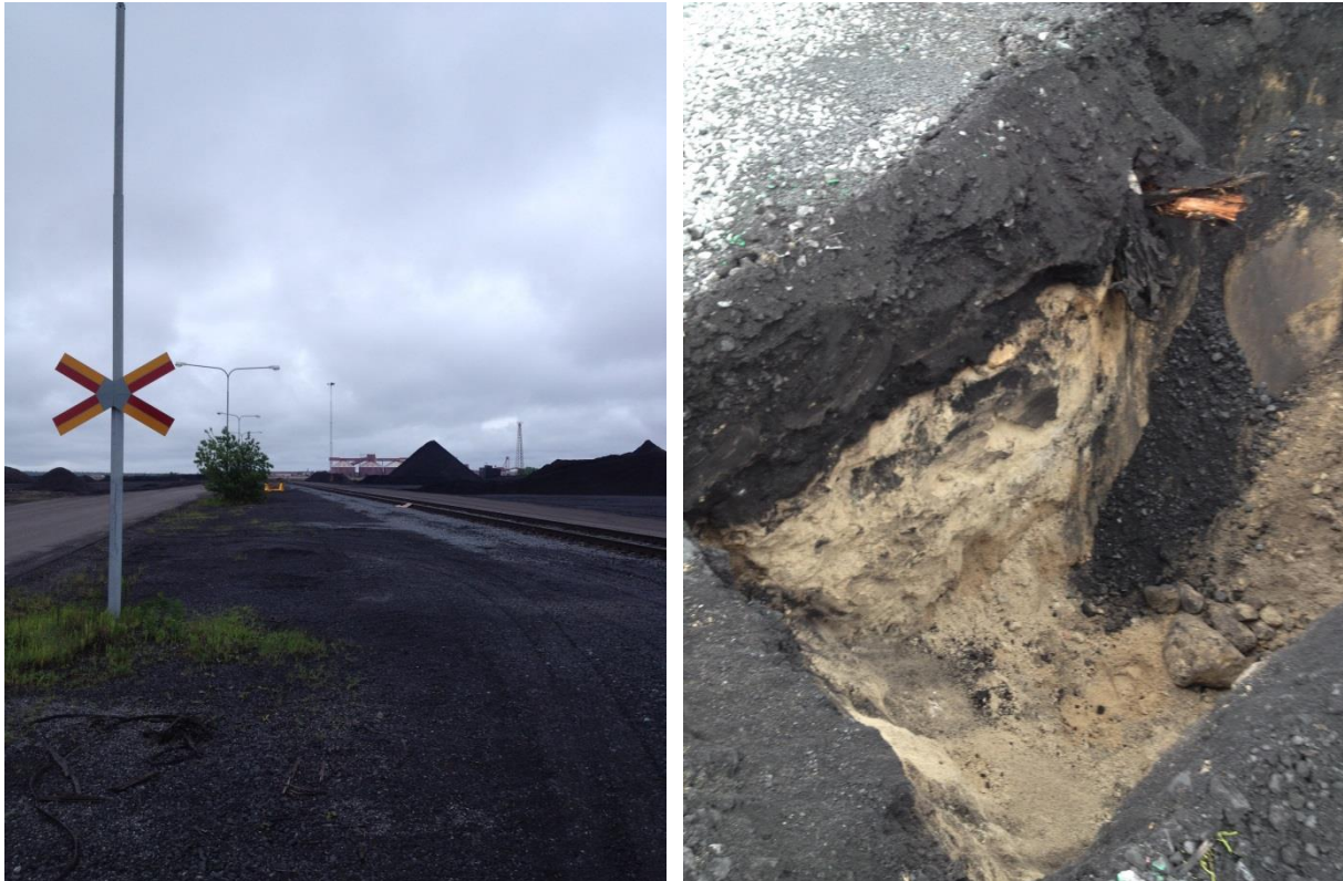
Figur 5.1.2: Markområde mellan väg och järnväg, vänstra bilden. Högra bilden visar generell jordlagerföljd för punkterna 14R13-14R15.
