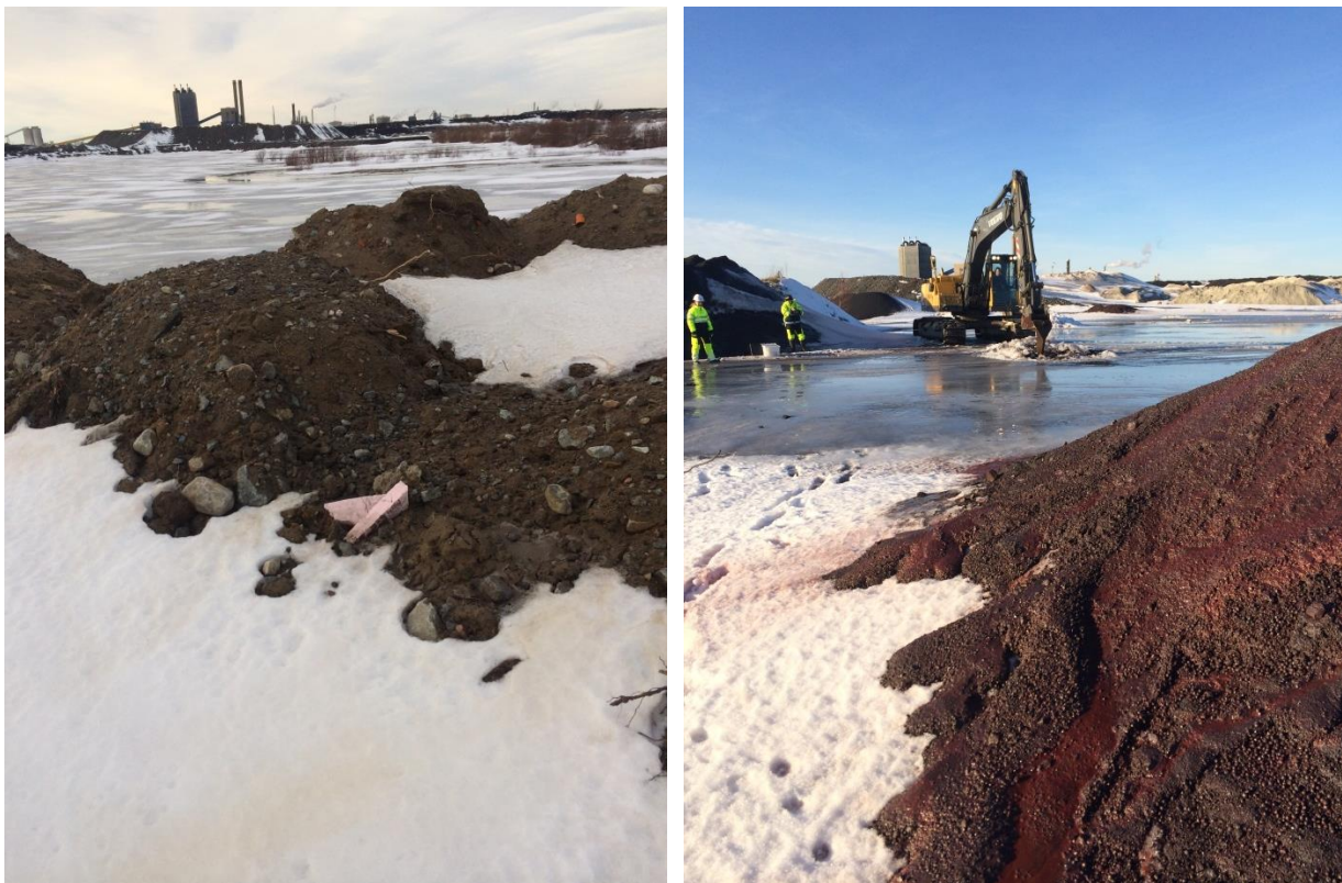
Figur 5.1.1: Fyllnadsmassor kring punkten 14R08, vänstra bilden. Högra bilden visar upplag av ”pellets fines” i närområdet till punkten 14R12.
