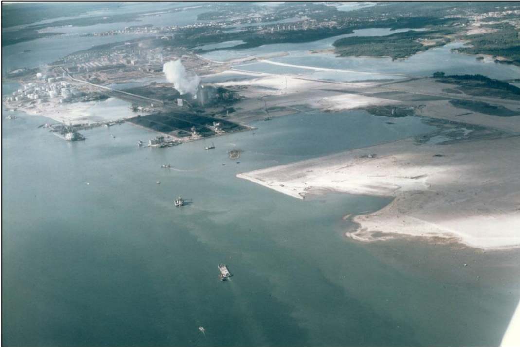
Figur 3.1.1.1 Utfyllnader under 1970-talet under det s.k. Stålverk 80-projektet. Av bilden framgår att utfyllnaderna av tidigare vattenområden utfördes med i huvudsak sand. Även befintlig fastmark (öar i området) kan ses.
