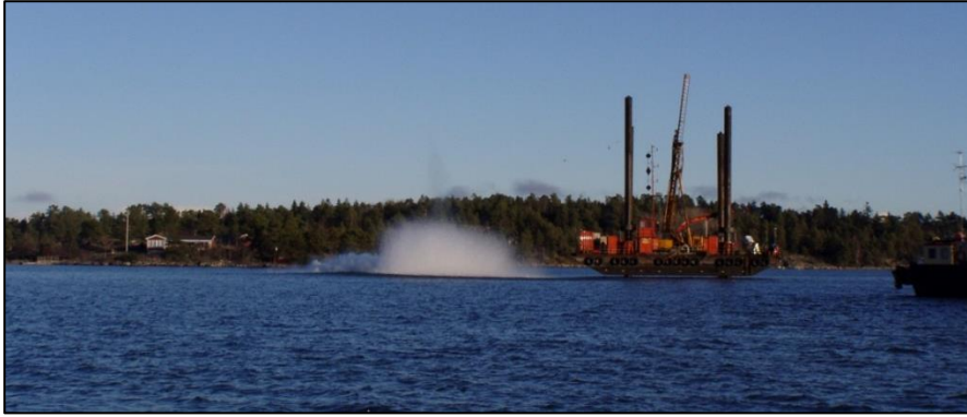
Figur 6.4.3.5 Undervattenssprängning med borrarplattform i väntläge.
