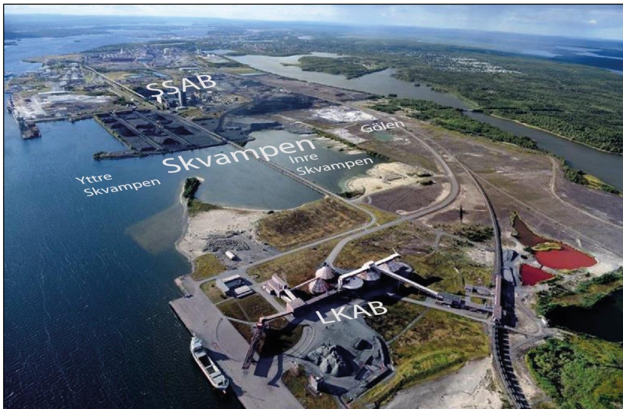
Figur 3.1. Nuvarande verksamheter på Svartöns industriområde. LKAB:s verksamhet på Sandskär i förgrunden, vattenområdet Skvampen i mitten samt SSAB:s verksamheter med kollager och stålverk etc. Luleå Hamns nuvarande kajer t.v. Malmkajen Sandskär närmast och Victoriahamnen med kolpiren utanför SSAB:s kollager. En praktisk uppdelning har gjorts av vattenområdena Yttre Skvampen och Inre Skvampen som avskiljs av en vägbank. Lågpunkten på landområdet där grundvattenytan står högt och bildar en vattensamling har av samma praktiska skäl benämnts Gölen.
