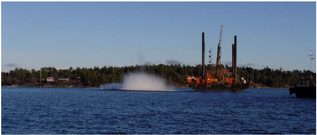
Figur 9 Undervattenssprängning med borrarplattform
