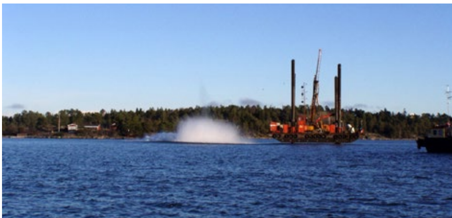
Figur 14, Undervattenssprängning med borrhplattform i väntläge.
