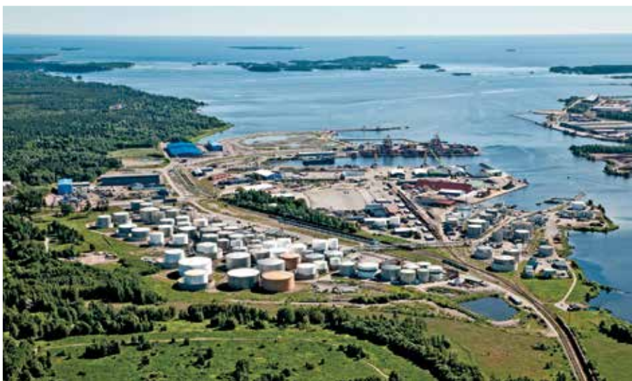
Gävle hamn. Projektet är det första farledsprojektet som finansierats med anslag via Trafikverket och Nationella planen för transportinfrastrukturen. Gävle kommun är medfinansierare.
